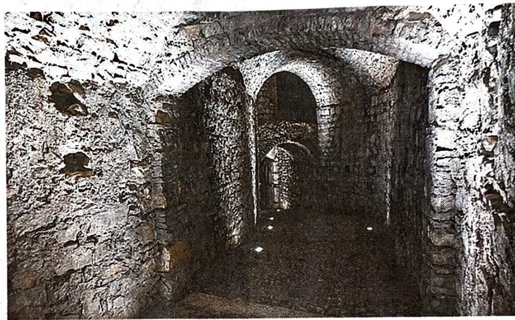
In Castello. La Strada del Soccorso è stata riaperta recentemente
