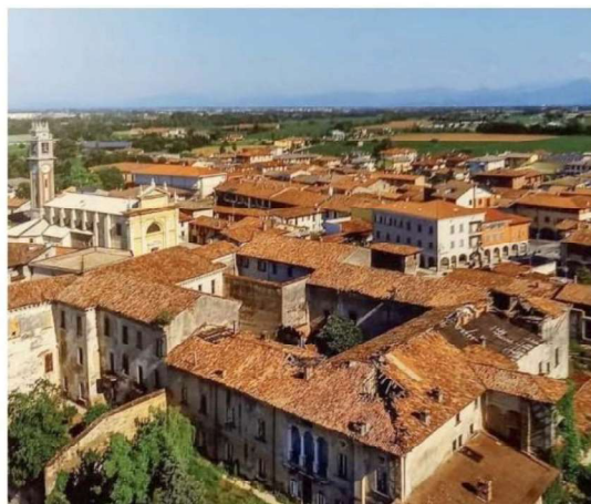
A Uraglio d'Oglio. Il castello mostra i tetti cadenti e le precarie condizioni di conservazione. // FOTOGRAFIE DI MAURO PEZZOTTA
