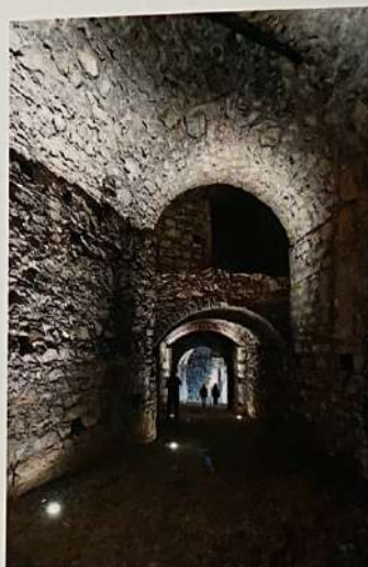
Nel tunnel. Il percorso al coperto // FOTOSERVIZIO NEG/ STRADA
